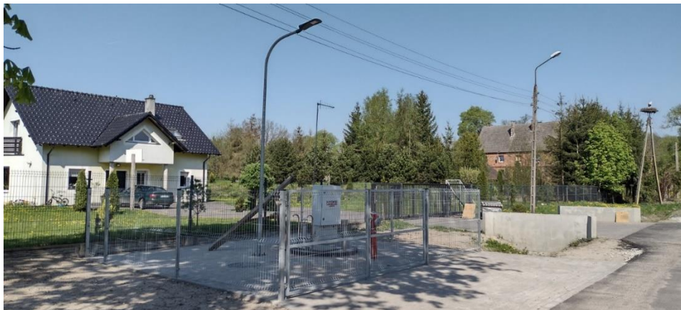
Fot. Wąsosz kanalizacja.
